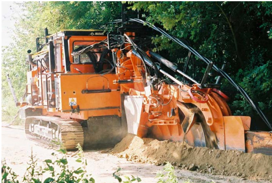
Σχήμα 6.2.2.5.3-2: Μηχάνημα τοποθέτησης καλωδίου για τα χερσαία τμήματα του υπό μελέτη έργου
