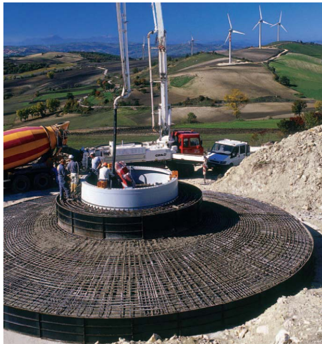
Σχήμα 6.1.3.2-2: Θεμελίωση Α/Γ ENERCON-E-70/2,3 MW
