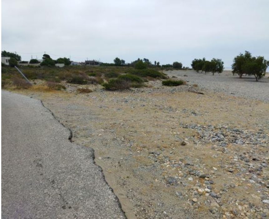
Φωτ. 1. Θέση αντλιοστασίου A1, εντός ζώνης παραλίας
