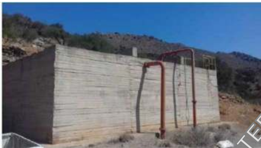
Δεξαμενή συγκέντρωσης Αγ. Λουκά που υδροδοτείται από την κεντρική δεξαμενή Λ μέσω του προωθητικού αντλιοστασίου Αγ. Λουκά και αρδεύεται βαρυντικά το ανατολικό τμήμα της περιοχής Μέσα-Εξω Λακωνίων
