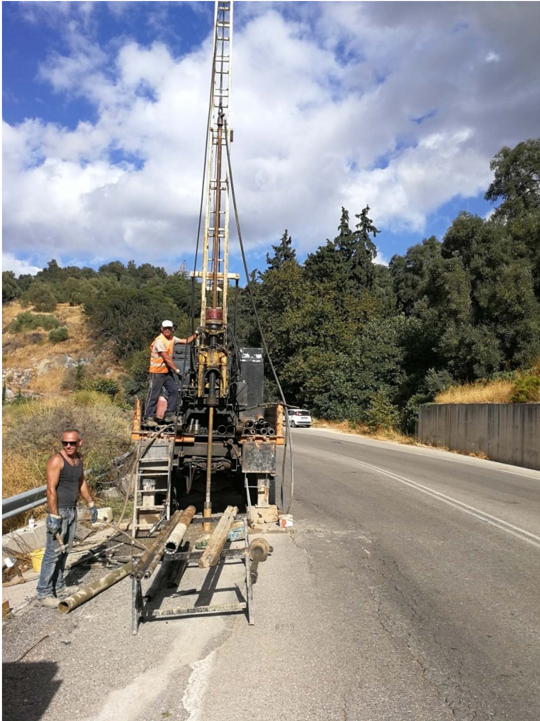
Φωτογραφία 4: Θέση διάνοιξης της δειγματοληπτικής γεώτρησης Χ23Π
