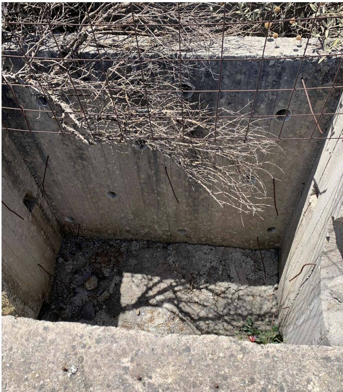
Εικόνα 2.5 - Λήψη 10/2019- Τεχνικό έργο αποστράγγισης.
