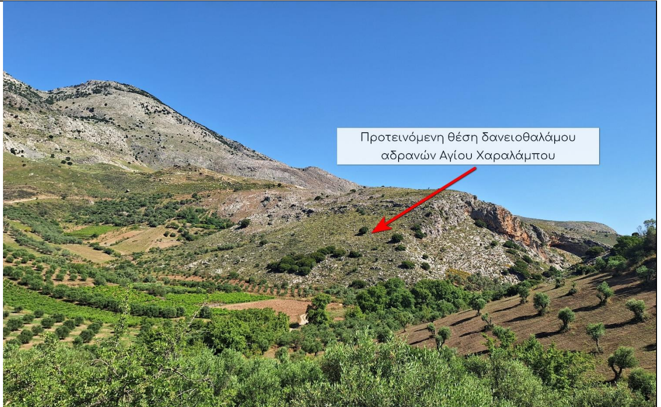
Εικόνα 10 Τωρινή κατάσταση (Ιούνιος 2023) στον προτεινόμενο για δανειοθάλαμο αδρανών χώρο, Αγίου Χαραλάμπους
