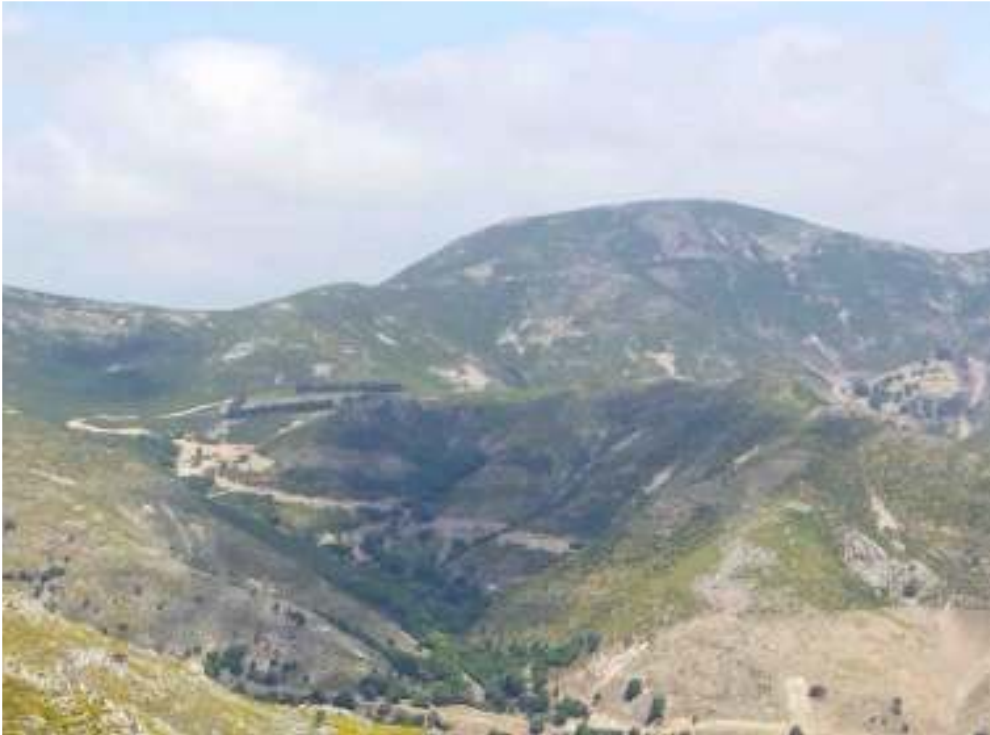
Φωτ. 2. Περιοχή επέμβασης, όπως φαίνεται από τον δρόμο της Σπίνας
