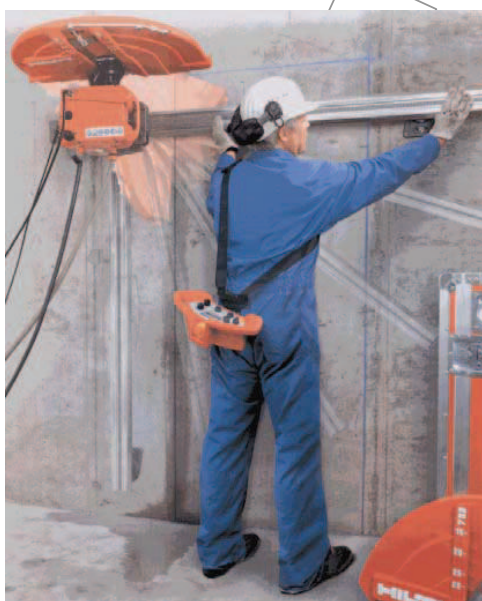
Σχήμα 2 - Κοπή τοίχου με δισκοπρίονο επί τροχιών καθοδήγησης
