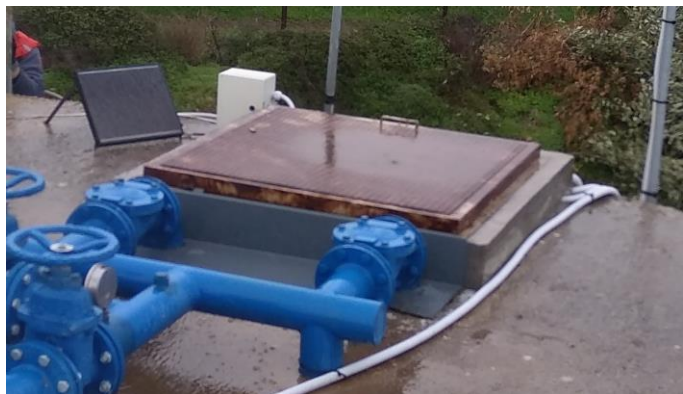
Φωτογραφία 12 – Κάλυμμα Δεξαμενής Δ
