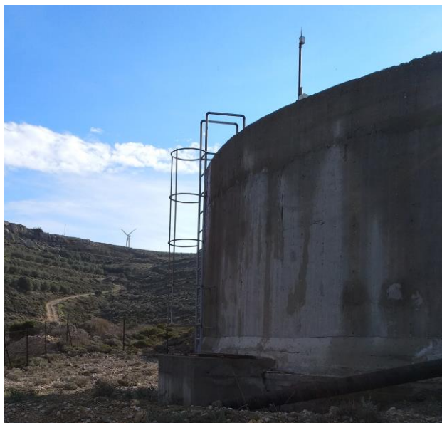
Φωτογραφία 1 – Δεξαμενή Α
