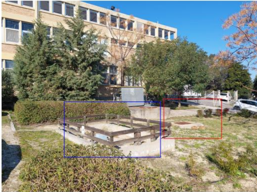
Εικόνα 5: Δεξαμενή υγραερίου και υπόγεια δεξαμενή συλλογής λιπών
