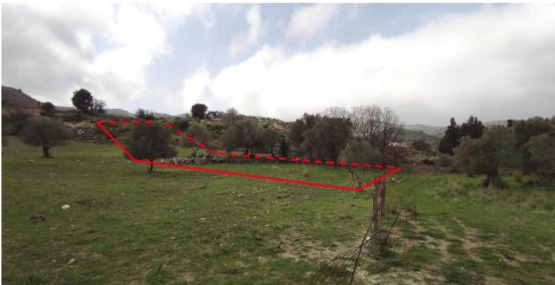
Φωτ. 3: Άποψη του γηπέδου της εγκατάστασης επεξεργασίας λυμάτων από σημείο κοντά στη βορειοανατολική γωνία, με λήψη από βορειοανατολικά προς νοτιοδυτικά, με σημειωμένο το όριο του γηπέδου.
