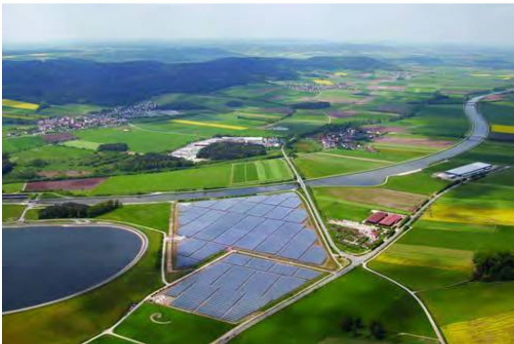
Σχήμα 7.2-1 Παράδειγμα Φωτοβολταϊκού σταθμού ηλεκτροπαραγωγής μεγάλης κλίμακας (πηγή: Σύνδεσμος Εταιριών Φωτοβολταϊκών).
