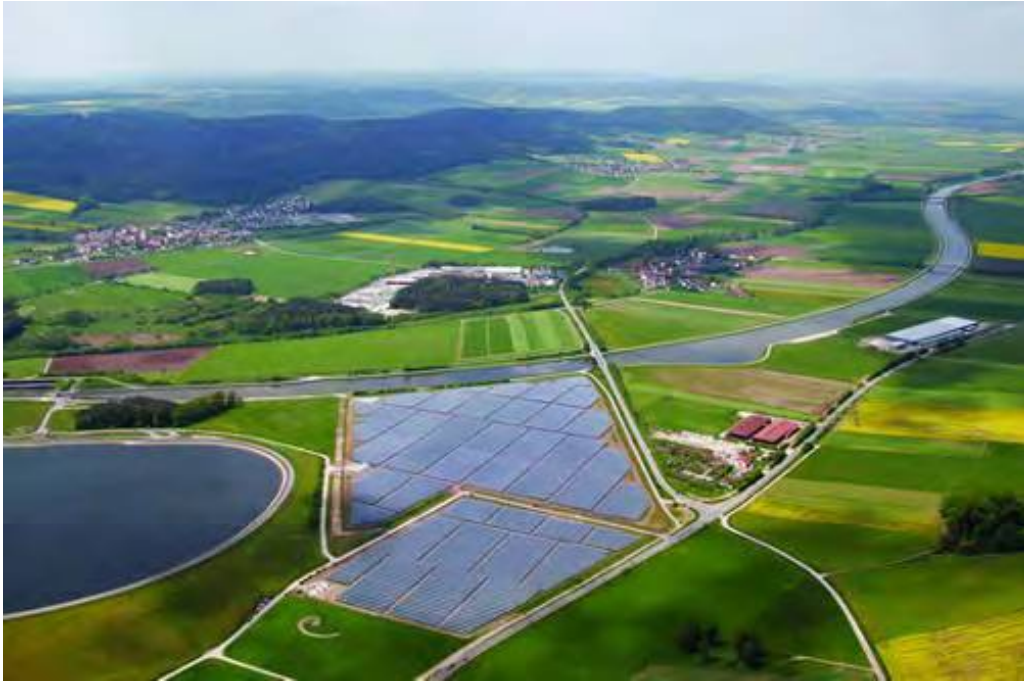
Σχήμα 2.4.3.1-1: Παράδειγμα Φωτοβολταϊκού σταθμού ηλεκτροπαραγωγής μεγάλης κλίμακας (πηγή: Σύνδεσμος Εταιριών Φωτοβολταϊκών).
