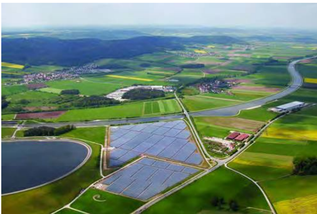
Σχήμα 7.3.1.1-1: Παράδειγμα Φωτοβολταϊκού σταθμού ηλεκτροπαραγωγής μεγάλης κλίμακας (πηγή: Σύνδεσμος Εταιριών Φωτοβολταϊκών).
