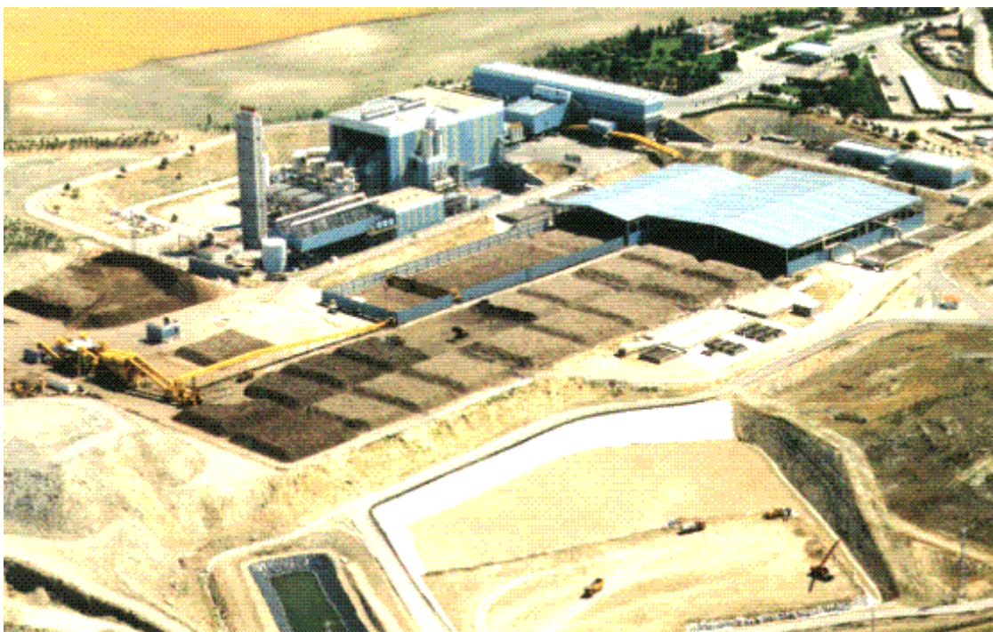
Σχήμα 7.3.1.1-2: Παράδειγμα Σταθμού Θερμικής επεξεργασίας αποβλήτων στο LAS LOMAS στα περίχωρα της Μαδρίτης δυναμικότητας 438.000 Κίτρα
