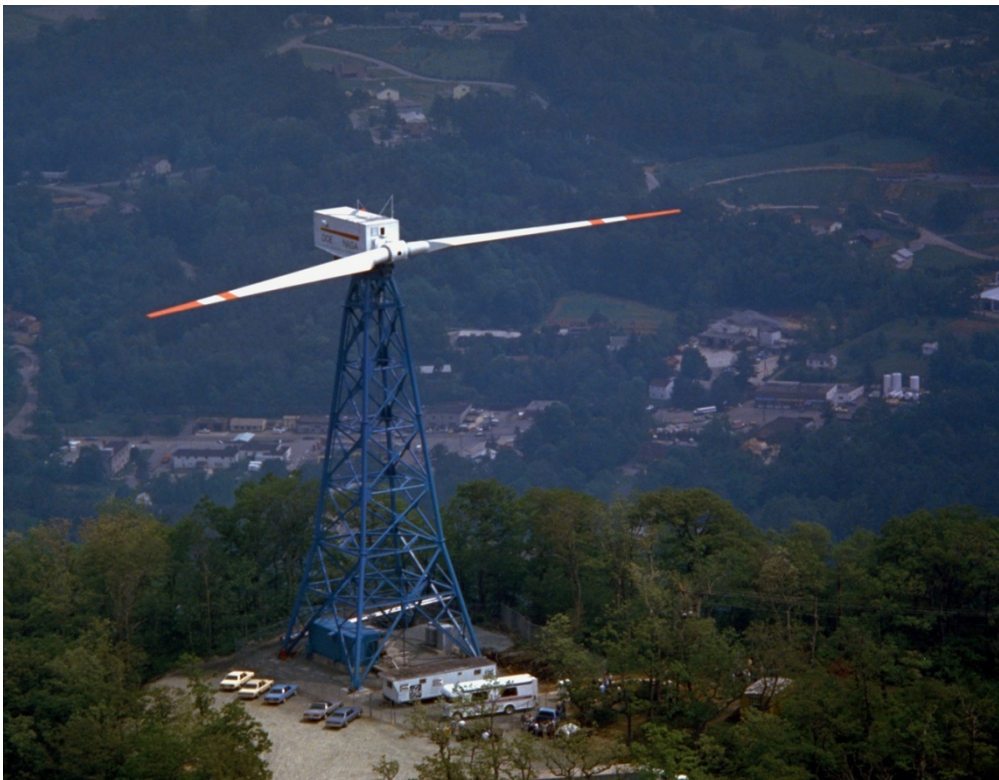
Σχήμα 9.2.2.2-1: Ενδεικτική φωτογραφία όπου απεικονίζεται ανεμογεννήτρια που στηρίζεται σε δικτυώματα.
