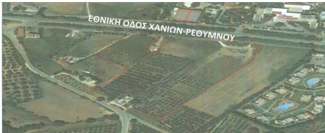
Υφιστάμενο Ξενοδοχείο «PILOT» της «ΑΣΤΕΡΑΣ Α.Ε.»
