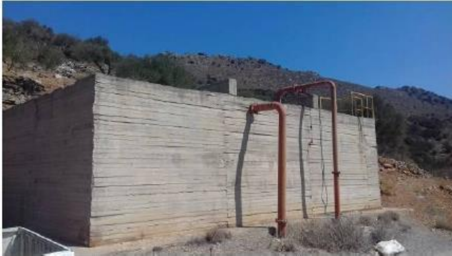
Δεξαμενή συγκέντρωσης Αγ. Λουκά που υδροδοτείται από την κεντρική δεξαμενή Λ μέσω του προωθητικού αντλιοστασίου Αγ. Λουκά και αρδεύεται βαρυντικά το ανατολικό τμήμα της περιοχής Μέσα-Έξω Λακωνίων
