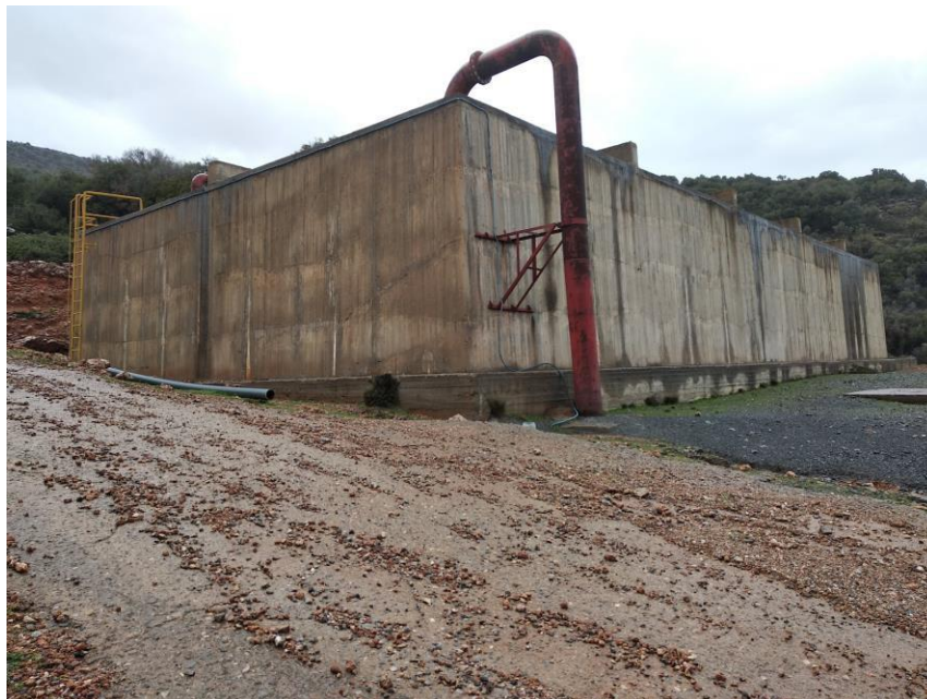
Κεντρική Δεξαμενή Λ που υδροδοτείται από τις γεωτρήσεις Λ1-Λ2-Λ3 μέσω του προωθητικού αντλιοστασίου Λ και αρδεύεται βαρυντικά η περιοχή Δ.Κ. Λιμνών
