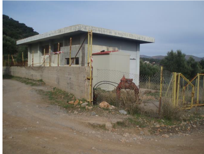
Γεώτρηση Λ1 και προωθητικό αντλιοστάσιο Λ
