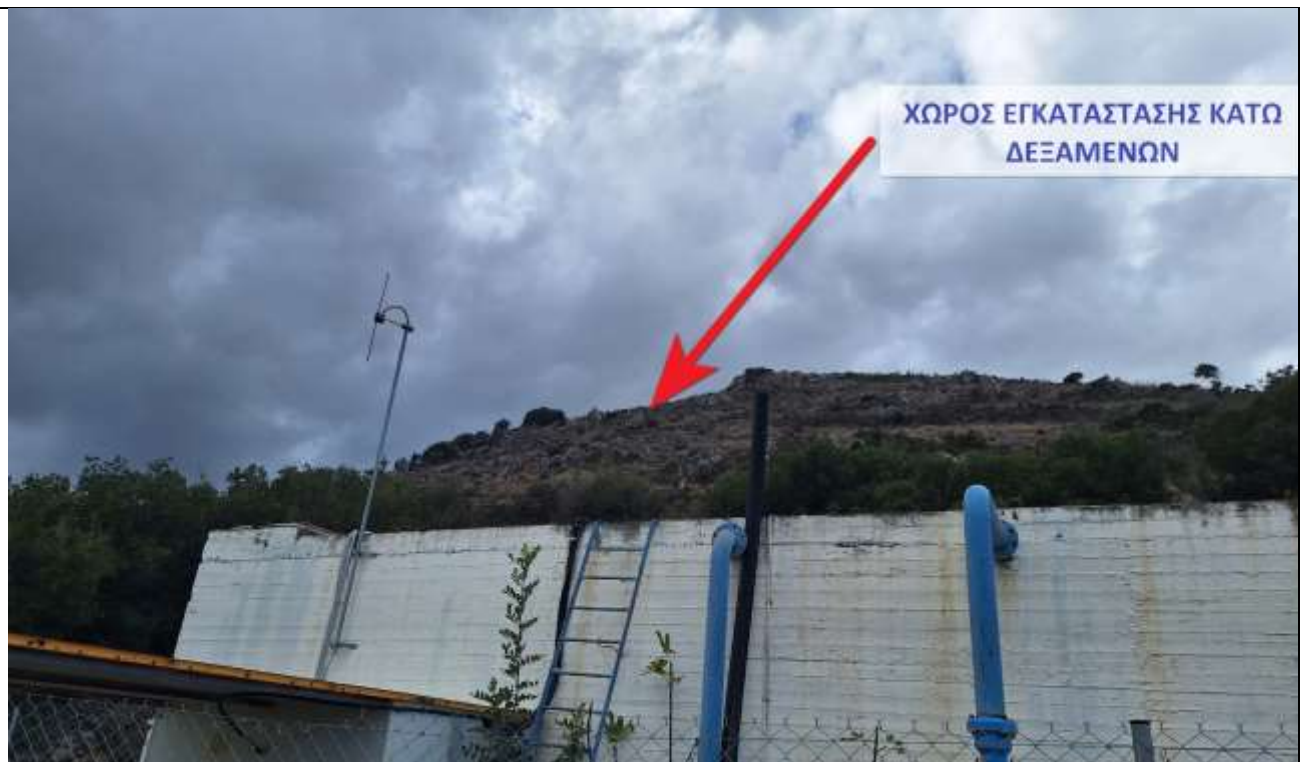
Εικόνα 11. Χώρος εγκατάστασης κάτω δεξαμενών
