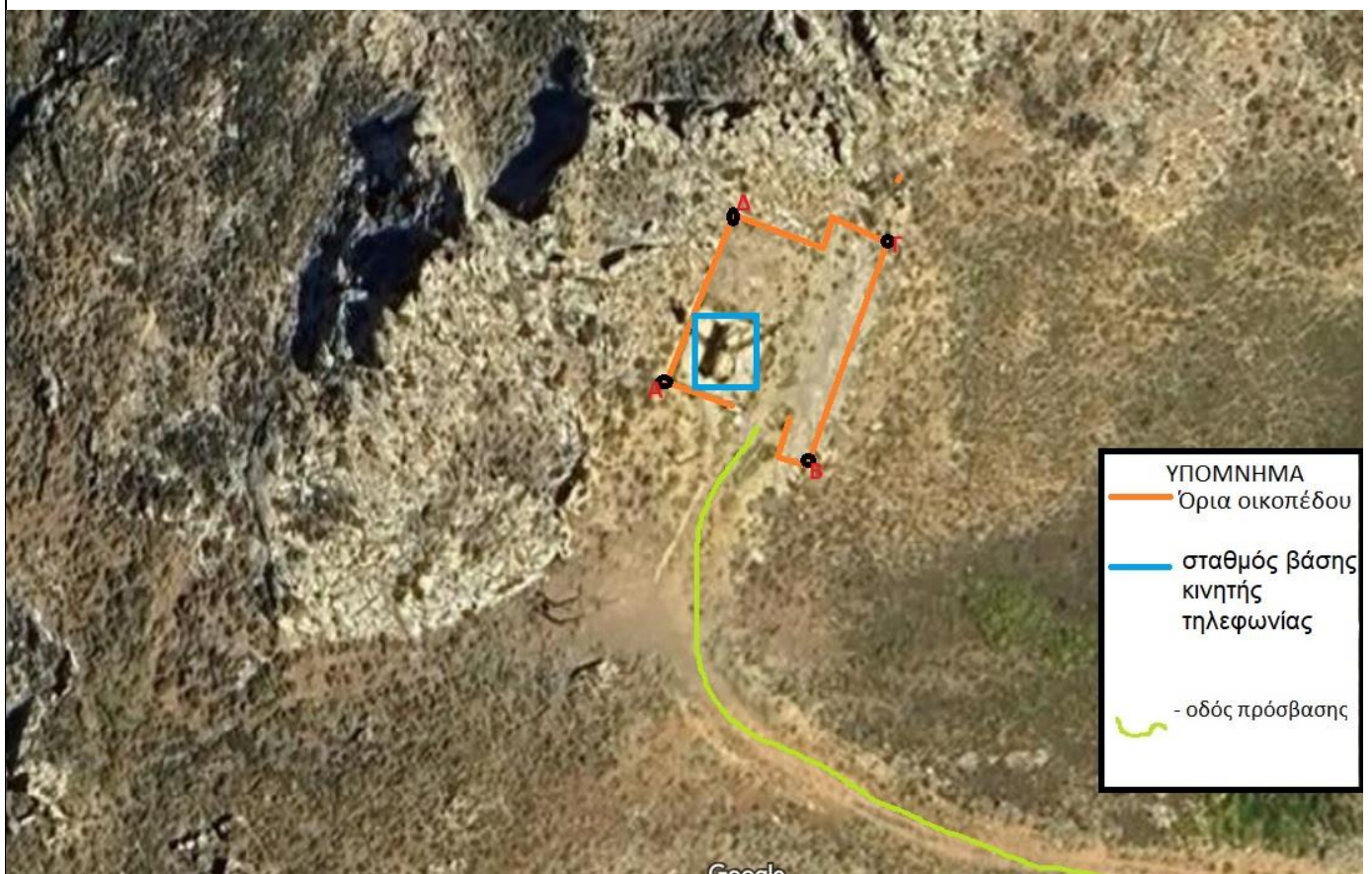
Εικόνα 2: Περιοχή εγκατάστασης Σταθμού βάσης κινητής τηλεφωνίας.
