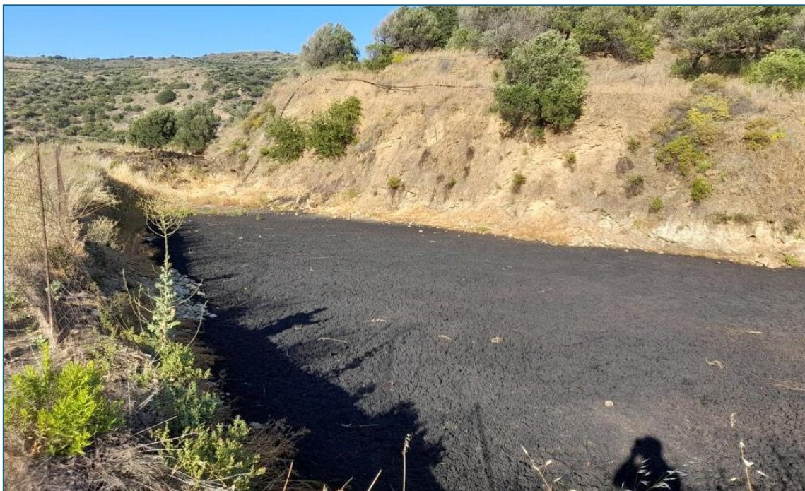
Αποψη εδαφοδεξαμενής εξάτμισης στη θέση «Πλατάνια»
