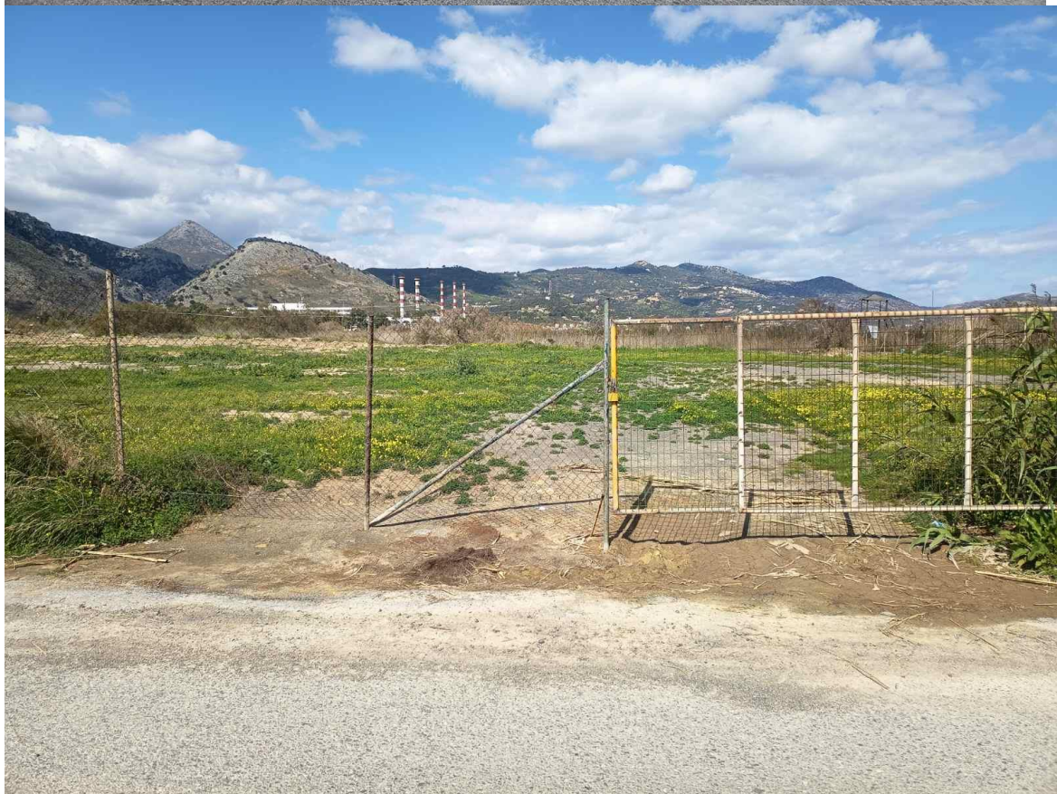
Εικόνα 1 & 2: Καθαίρεση πινακίδας - Τοποθέτηση εμπόδιο εισόδου
