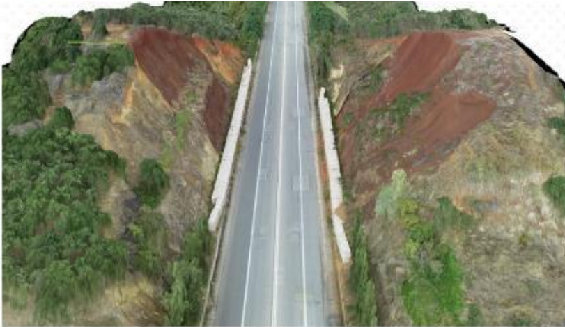
Εικ.3: Απεικόνιση του υφιστάμενου ορύγματος της Χ.Θ. 28+200 με τις δύο κατοικίες εκατέρωθεν, με καταπτώσεις και έργα συγκράτησης των πρανών. (Εικόνα Β22, σελ. 307 ΜΠΕ).
