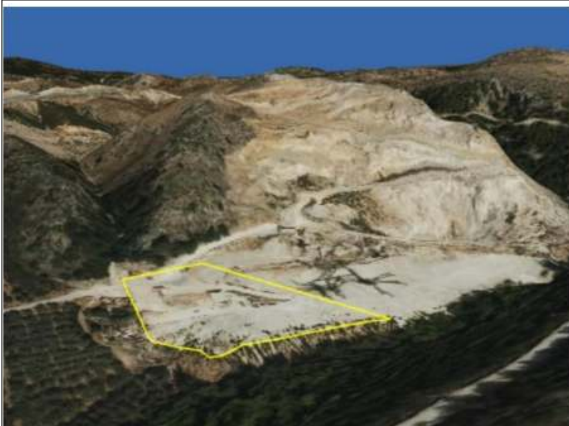
Εικόνα 3: Φωτογραφία της έκτασης στην οποία πρόκειται να εγκατασταθεί η «Μονάδα παραγωγής έτοιμου σκυροδέματος & ασφαλτομίγματος» στη θέση Κακόσκαλα εκτός της λατομικής περιοχής Καντάνου του Δήμου Καντάνου-Σελίνου Π.Ε. Χανίων (Εικόνα 23 της ΜΠΕ).
