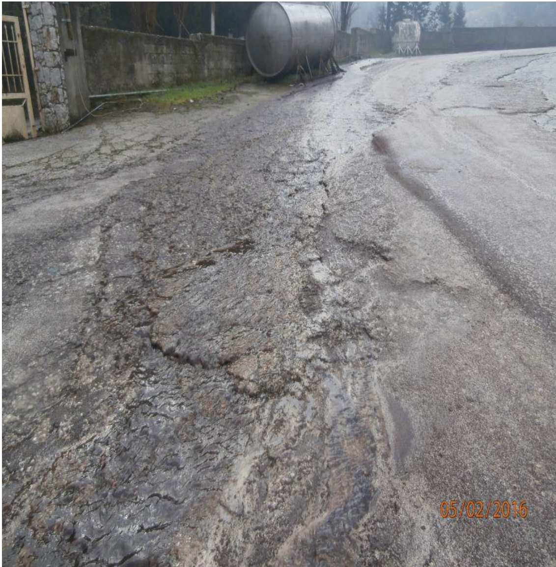
Φωτ. 2. Όδευση ομβρίων με στραγγίσματα στο δρόμο που οδηγεί στο χώρο παραλαβής (05-02-2016)
