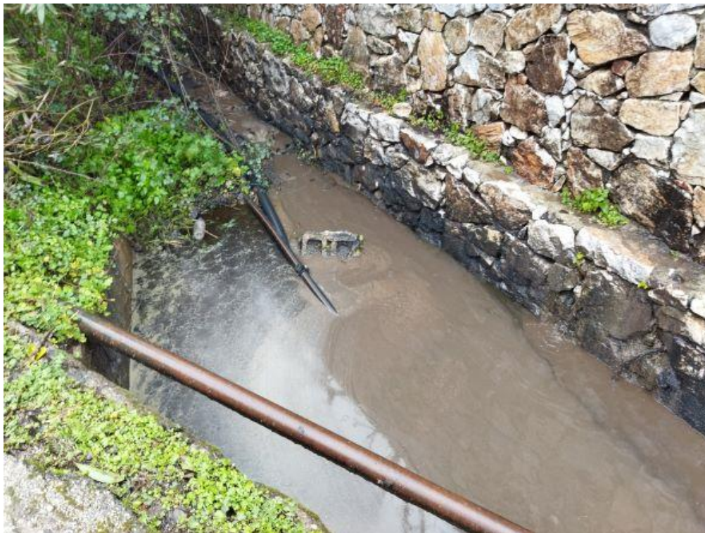
Φωτ. 3. Διαρροές στραγγισμάτων εκτός της εγκατάστασης (13-01-2022).
