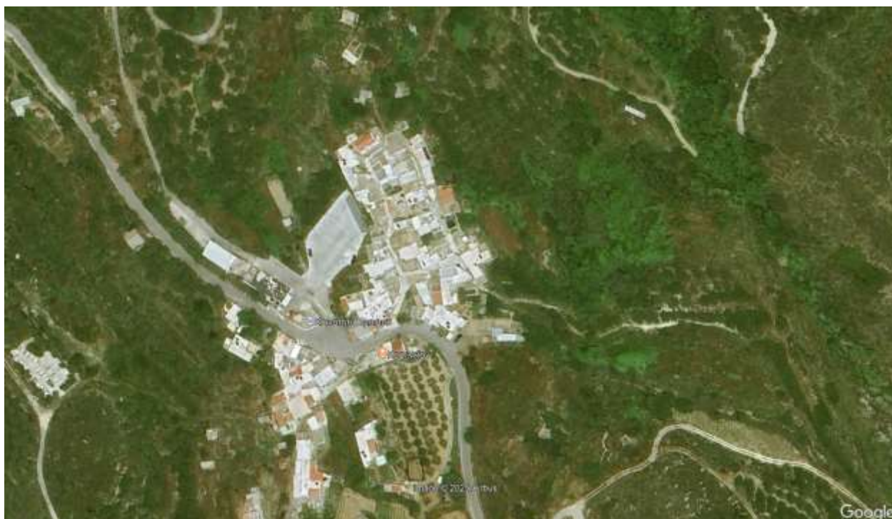
Αεροφωτογραφία του οικισμού της Νέας Πραισού και με κόκκινο περίγραμμα το εξεταζόμενο ελαιουργείο (εκτός του συνεκτικού τμήματος του οικισμού).
