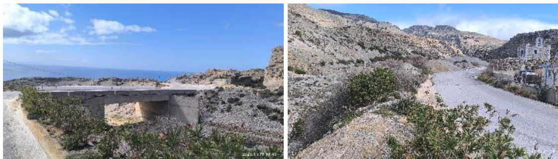
Εικόνες 10 και 11: Το παρακείμενο οριοθετημένο υδατόρεμα στη μονάδα παραγωγής σκυροδέματος και αδρανών υλικών της «Ιωάννης Χατζηδάκης και ΣΙΑ Ο.Ε.» από την αυτοψία της υπηρεσίας μας στις 19-3-2026.
