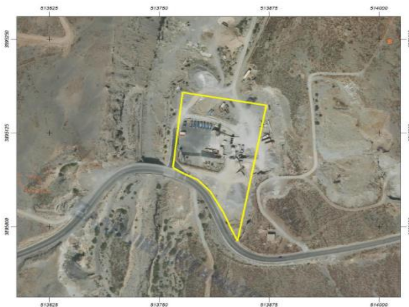
Εικόνα 1. Αεροφωτογραφία του GOOGLE EARTH με την έκταση της μονάδας παραγωγής σκυροδέματος και αδρανών υλικών της «Ιωάννης Χατζηδάκης και ΣΙΑ Ο.Ε.» στη θέση
