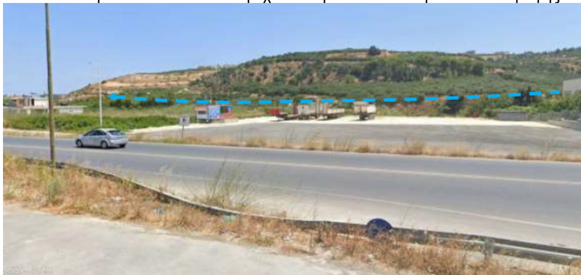
Εικόνα 5: Περιοχή διαμόρφωσης ισόπεδου κυκλικού κόμβου IK1-A. Στο βάθος διακρίνεται ο Ξηροπόταμος.
