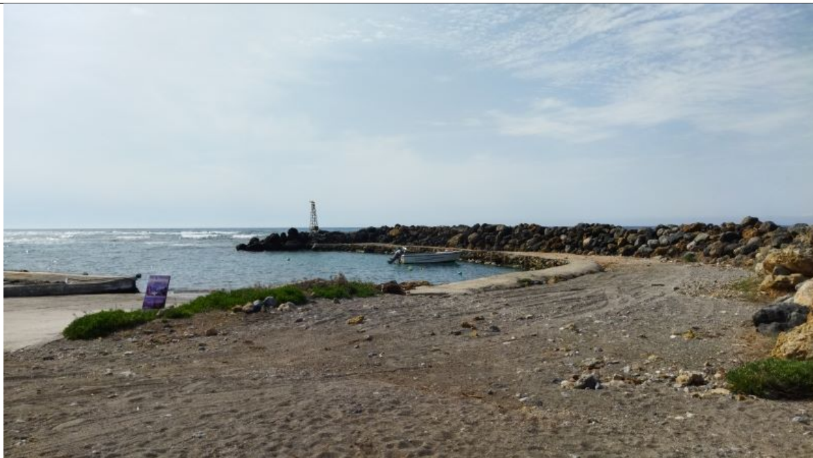
Φωτ. 1. Λιμενίσκος Φραγκοκάστελλου στις 15/04/2026 (προσήνεμος μώλος, υπήνεμος μώλος και παραλιακά κρηπιδώματα, και θωράκιση από ογκόλιθους).
