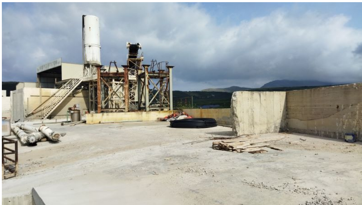
Φωτ. 1. Θέση μίξερ, βάσεις για σιλό τσιμέντου, αποθήκη αδρανών.
