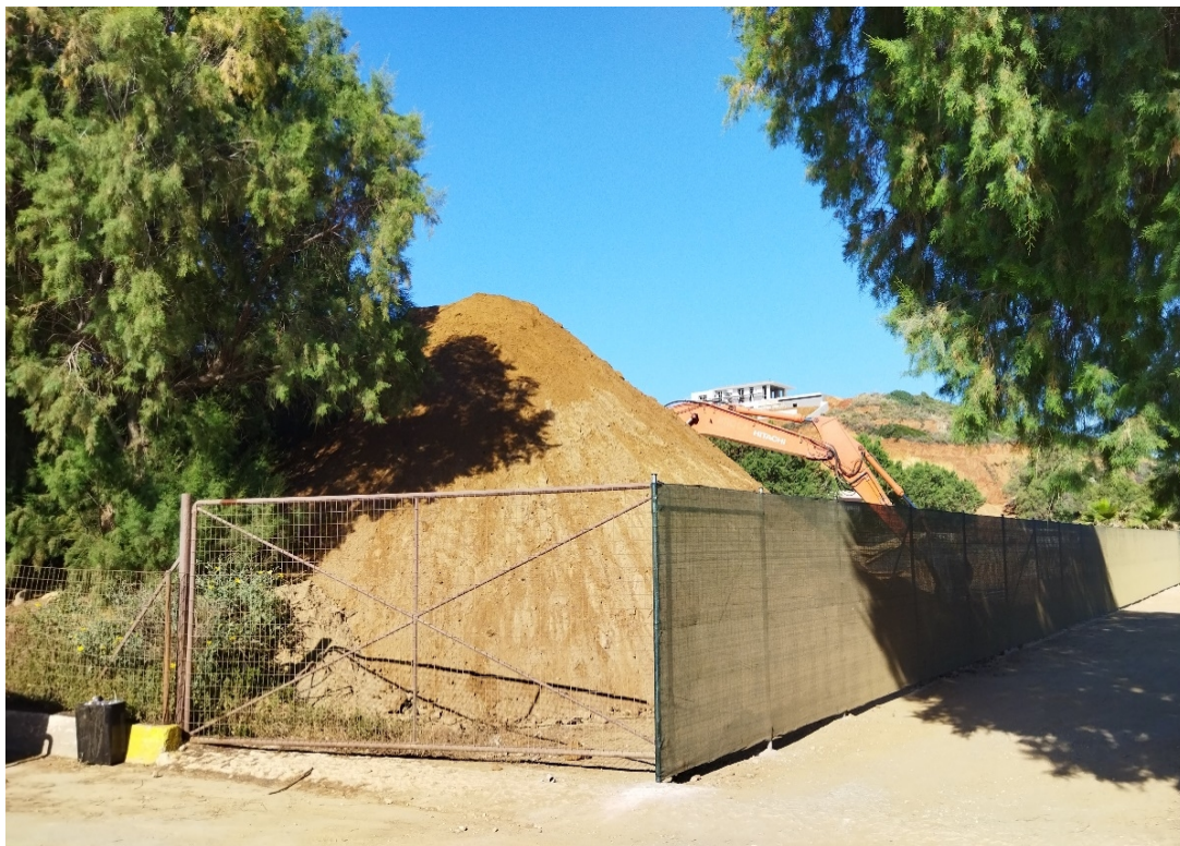
Φωτ. 1. Εκσκαφές για την ανέγερση της νέας ξενοδοχειακής μονάδας
