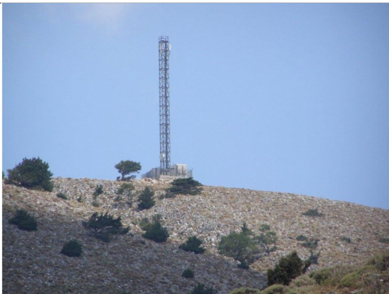
Εικόνα 2: Άποψη του σταθμού βάσης
