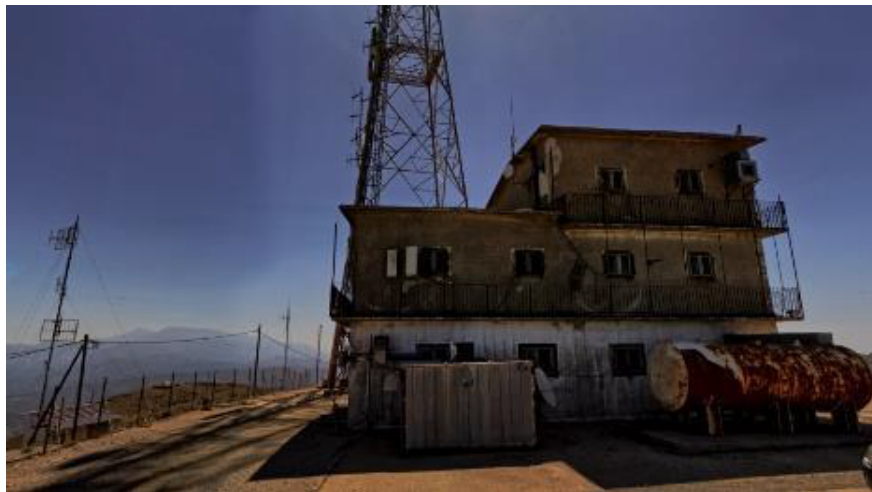
Εικόνα 2. Υφιστάμενη εγκατάσταση ΚΕΨΕΤ.
